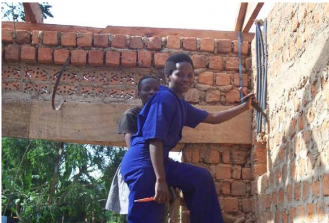
Regina Katushabe při instalaci elektřiny v nových třídách.
